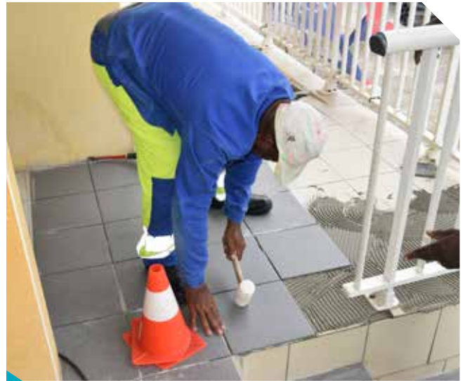
Pose carrelage antidérapant au Centre Nautique
