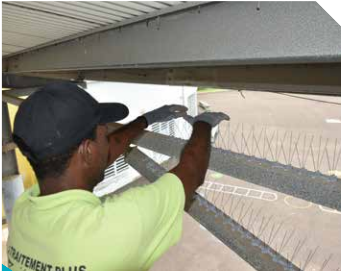
Installation de piques anti-pigeons à l'école Emile Capgras
