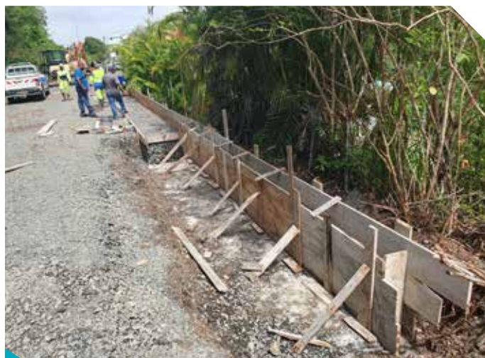
Construction d'un mur de soutènement et reprise du revêtement d'une portion de la chaussée à Pointe Savane
