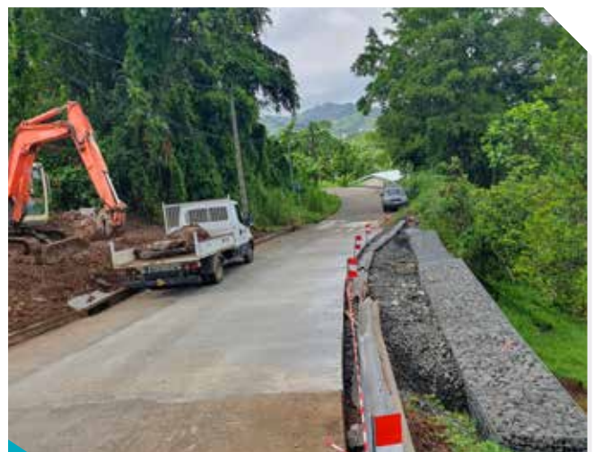
Construction d'un mur de soutènement et reprise du revêtement d'une portion de la chaussée à Bois Neuf
