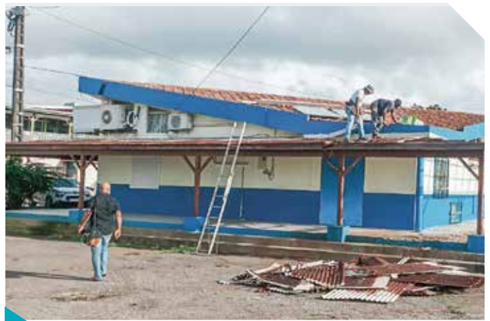
Réparation de la toiture de l' Office Municipale de la Culture et des Loisirs
