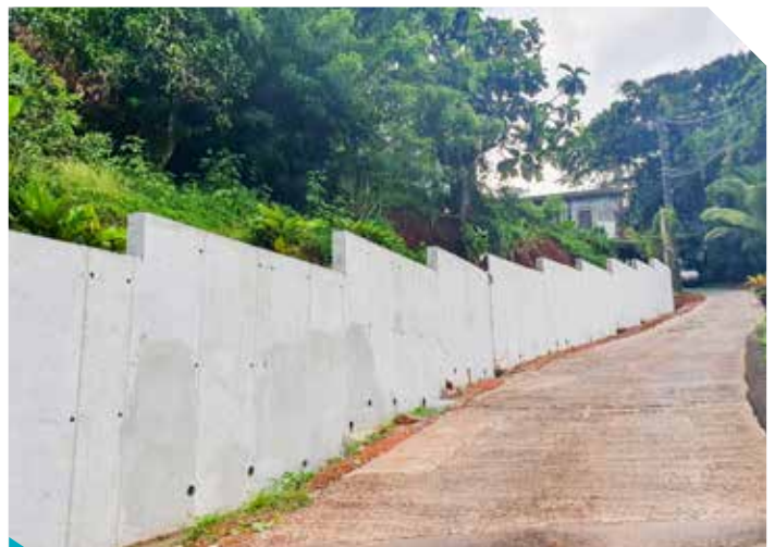
Construction d'un mur de soutènement à Galette
