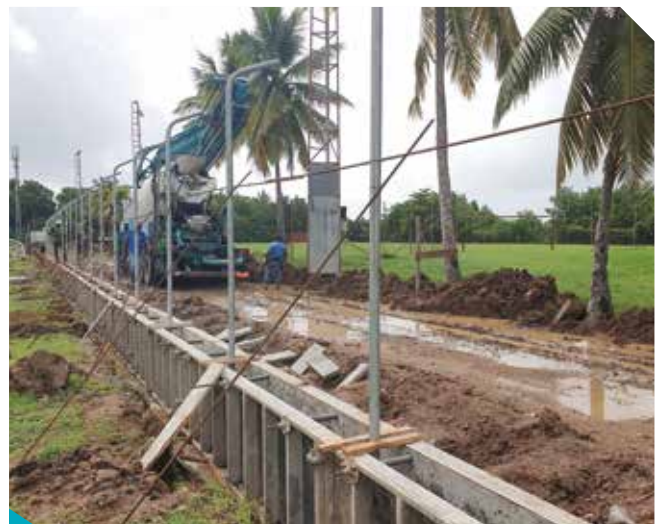
Travaux de reprise de la clôture de l'aire de jeu au stade Georges Spitz
