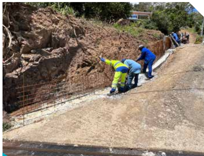
Réfection d'un chemin à Monnerot
