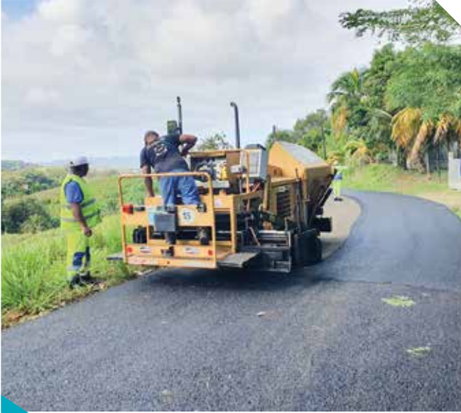
Réfection des routes dans les quartiers : Berthout, Augrain Sud, Hauteur Four à Chaux, Hauteur Pontaléry et En Secret
