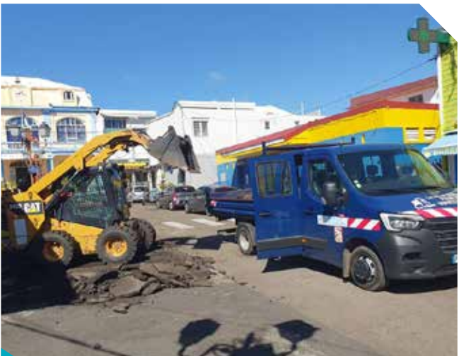
Réfection du parking du Bourg (place Abbé Morland)
