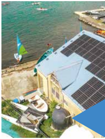
Mise en place de panneaux solaires au Robert
