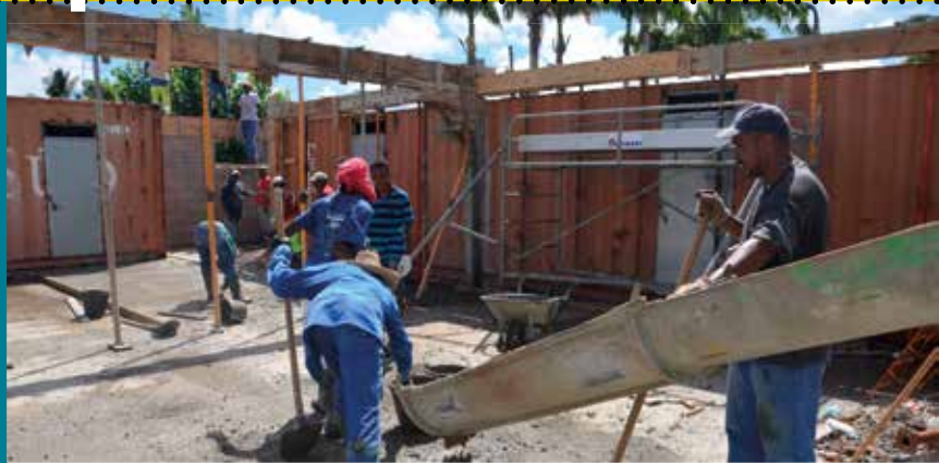
Construction des vestiaires de la piste d'athlétisme
