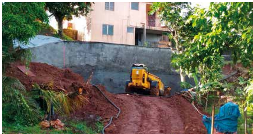
Murs de soutènement à l'Heureux dans le cadre de lutte contre les catastrophes naturelles pour protéger les habitations
